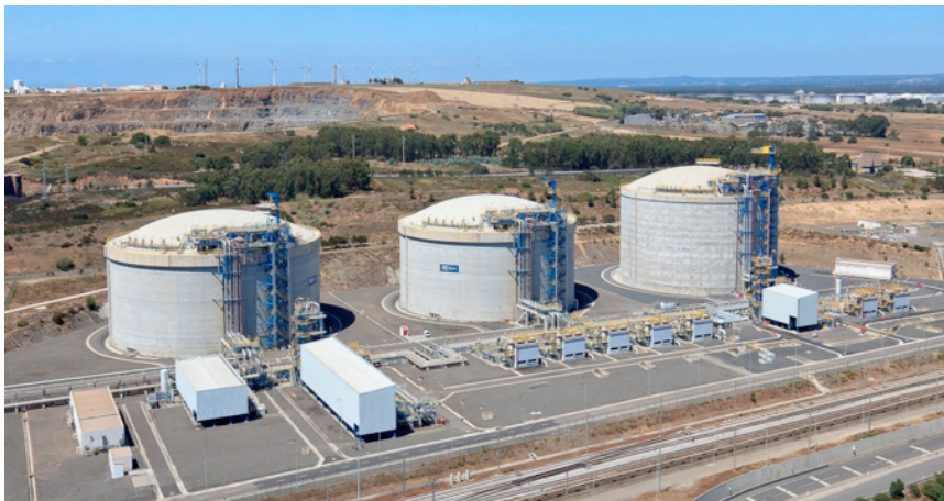
Terminal GNL – Armazenagem
