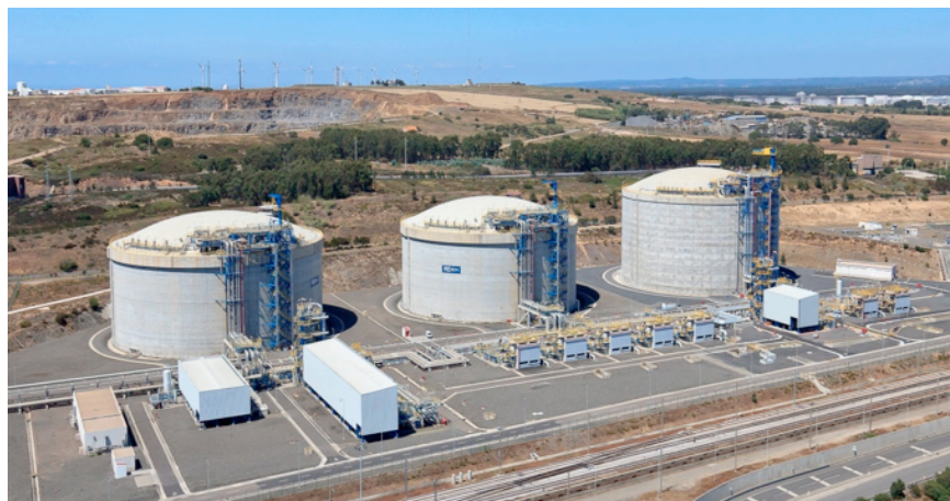
LNG Terminal - Storage
