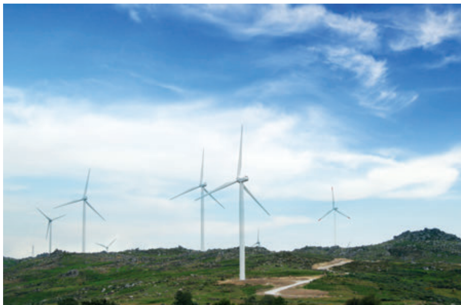
Parque eólico de São Macário II: deixou de ter limitação na sua potência de ligação, na sequência de uma reestruturação da topologia da rede, que permitiu redirecionar a sua produção para os 60 kV da subestação do Carrapatelo em vez dos 60 kV da subestação do Torrão, a partir de 3 de junho de 2011.
