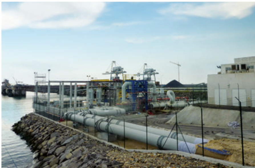
Nova tomada de água do mar.
