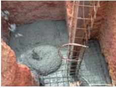
Figura 10 - Betonagem do cabouco
