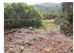
Figura 5 - Sinalização dos acessos aos apoios
