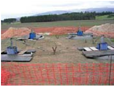
Figura 11 - Vista geral após betonagem
