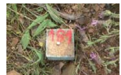
Figura 8 - Marcação de cabouco
