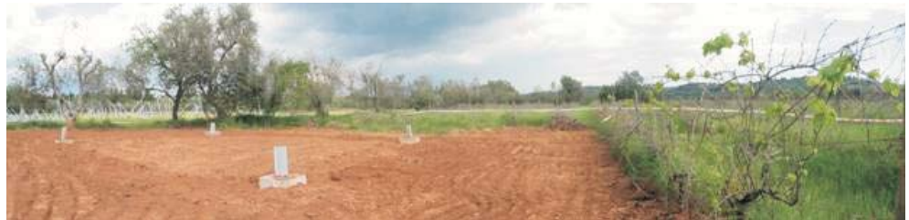
Figura 12 - Vista geral da área desmatada e dos caboucos implantados
