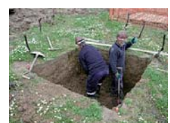
Figura 9 - Escavação de cabouco
