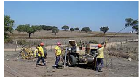
Figura 15 - Equipamento de desenrolamento
