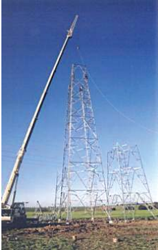
Figura 14 - Montagem de apoio
