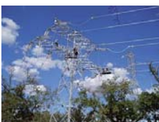
Figura 17 - Amarração de cabos
