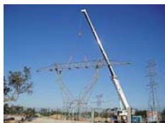
Figura 24 - Dismontagem de linha
